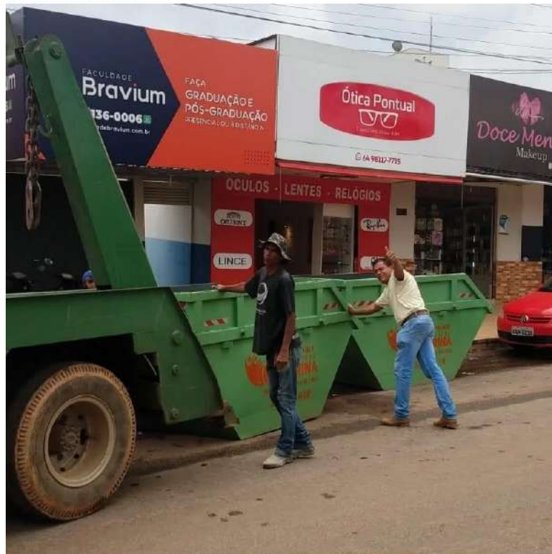
Figura 41. Caçambas para descarte de resíduos da construção civil.
